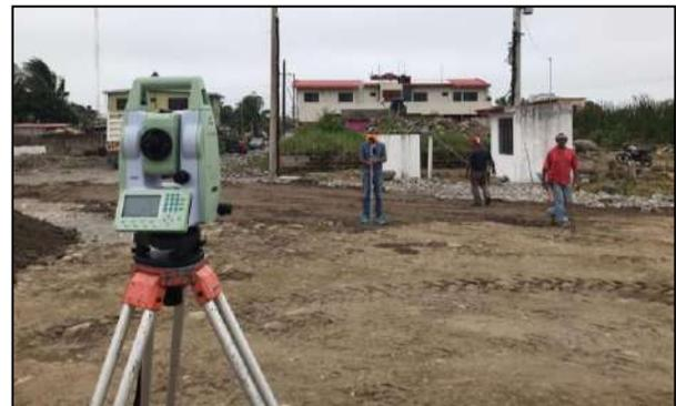
Figura 6. Trazo y nivelación del área de trabajo y rectificación de niveles para la compactación del revestimiento.
