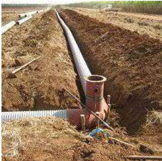
Figura 4. Diseño de sistema de riego con tuberías y multicpuertas. Fuente: Oscar Brown Manrique (Oliver, 2014)
