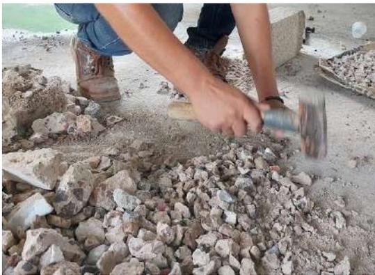
**Figura 1. Trituración del material de residuos de construcción (autor propio).**
