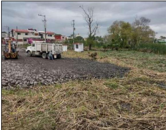
Figura 7. Suministro de material granular para la conformación del sitio.
