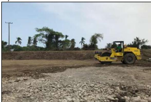
Figura 8. Capa de material de revestimiento para desplante de la estructura.
