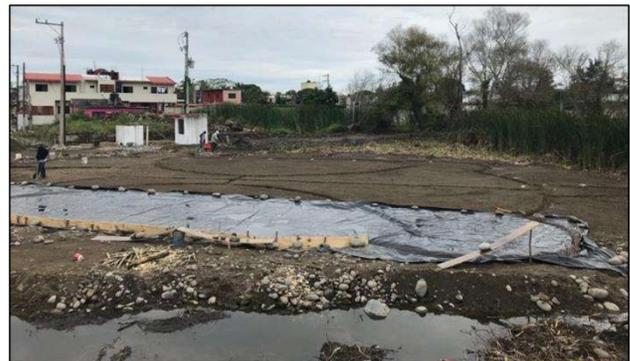
Figura 7. Colocación de geotextil en el desplante de la cimentación del sistema.
