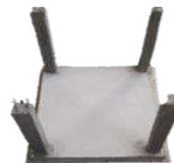
Figura 4. Construcción de los cuatro castillos para soporte del techo del prototipo.
