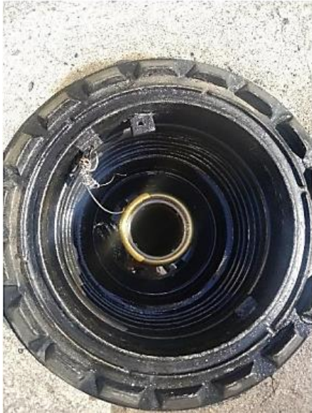
Ver figura 6. Entrada al depósito.
