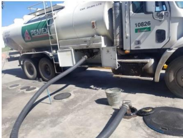
Ver figura 2. Inicio de proceso de descarga.
