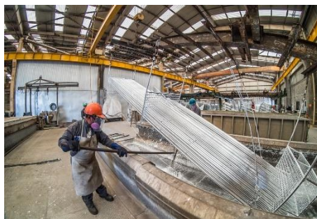
Figura 6. Varilla de acero de refuerzo saliendo de la paila de galvanizado. Tomado de archivos internos de Metalyzinc S.A. de C.V.
