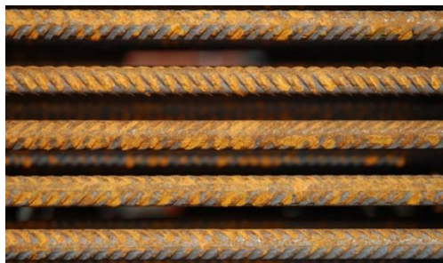
Figura 2. Varilla corrugada de acero con presencia de corrosión. Fuente: http://www.mndelgolfo.com
